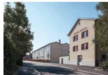
Wegen der schwachen Bausubstanz musste der Kopfbau der Töpferei nochmals errichtet werden.
