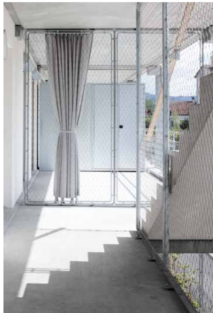
Drahtnetze und Vorhänge dienen als Filter im Bereich der Balkone und Erschliessungszonen. Die Bewohner können so individuell Offenheit und Intimität wählen.
