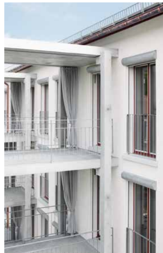
Die zweifarbigen französischen Fenster geben der Fassade Tiefe. Es wurde dasselbe Fensterformat für alle Fassaden verwendet.
