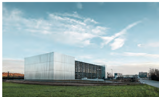
Treppenturm und Hochregallager sind mit Trapezblech verkleidet.
