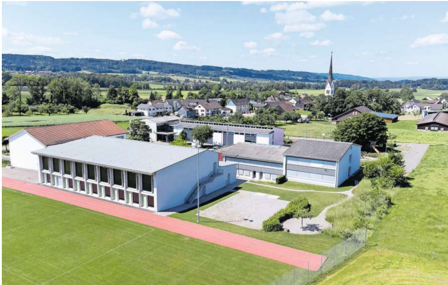
Die Schulanlage in Alterswilten soll erweitert werden.
