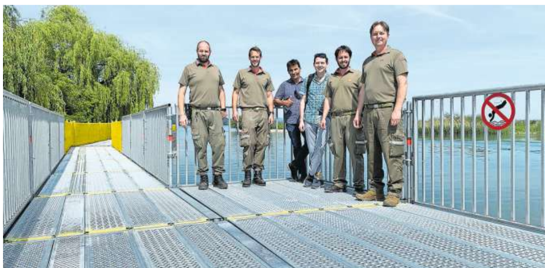
Der provisorische Steg bei Klein Venedig steht.
