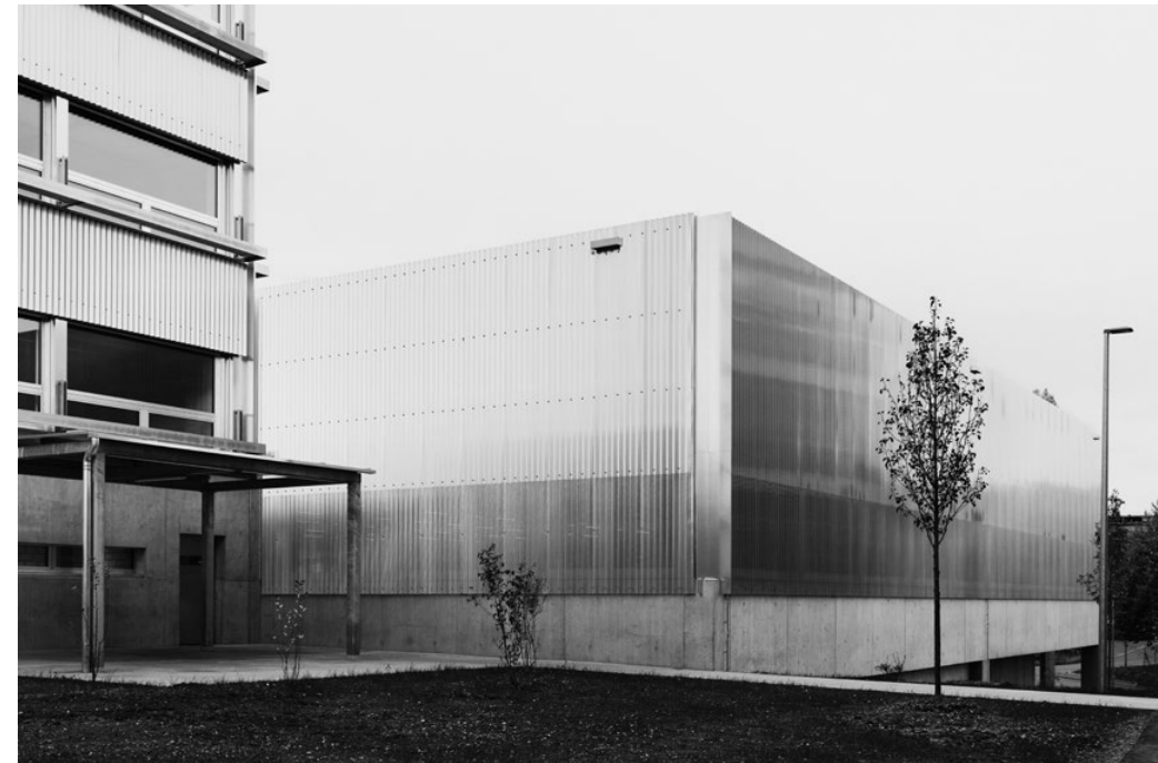
Die Produktionshalle der Firma HB Therm fügt sich nahtlos an den Hauptbau an, ist aber konstruktiv so von ihm getrennt, dass es keine Übertragung von Lärm und Vibrationen gibt. Von aussen wirkt die Halle wie ein geschlossenes Volumen. Tatsächlich erlaubt die Perforierung der Aluminiumbleche aber einen nahezu uneingeschränkten Blick von innen nach aussen.
